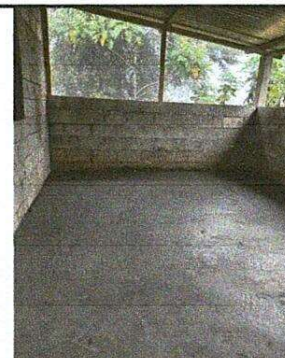
Foto 6: reparacion de mezcla de piso de torta para cocina.
