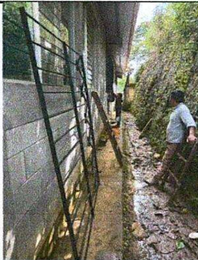
Foto 3: REPARACION DE BALCONES DE METALES PARA LA SEGURIDAD DEL EDIFICIO ESCOLAR
