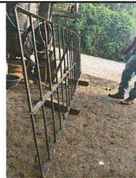
Foto 4: INSTALACION DE BALCON PARA BAÑO DE MUJERES DE 0.85 m x 3 m.
